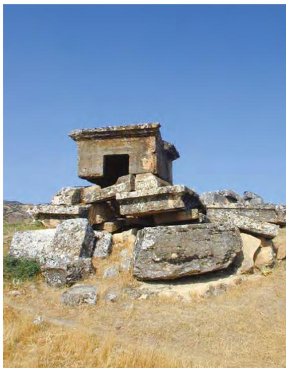
Fig. 87 Tomba 85, in evidenza il volume della camera ricavato in un unico blocco e appoggiato sugli elementi di base (2002).
