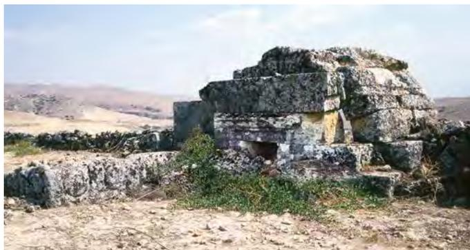
Fig. 93 Tomba D16 nella Necropoli Sud-Est (1986), la fronte d'ingresso con vista del rinfiacco della volta di copertura.
